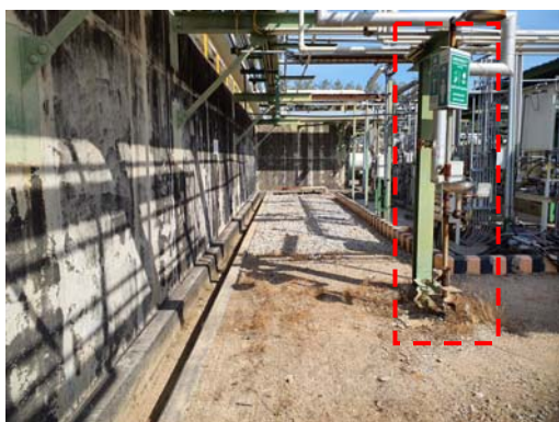
รูปที่ 3.1-38 จุดชำระล้างร่างกาย และล้างตาฉุกเฉิน
