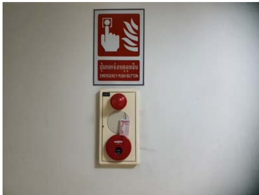
รูปที่ 3.1-50 ระบบตรวจจับและแจ้งเตือนไฟไหม้
