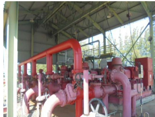
รูปที่ 3.1-52 บ่อน้ำสำรอง และปั้มน้ำดับเพลิง
