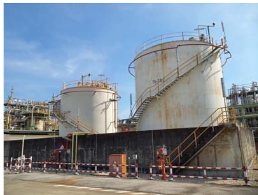
รูปที่ 3.1-43 คั่นคอนกรีต บริเวณถังเก็บกากเฮกเซน (TK-702, TK-703)
