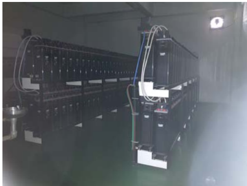
รูปที่ 3.1-48 ระบบเบตเตอร์สารอง
