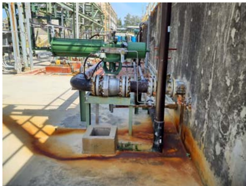
รูปที่ 3.1-8 Control Valve
