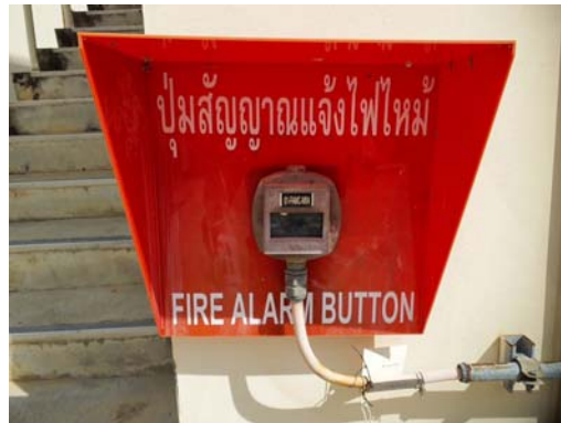
รูปที่ 3.1-50 ระบบตรวจจับและแจ้งเตือนไฟไหม้
