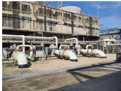
รูปที่ 3.1-9 ระบบน้ำหล่อเย็น
