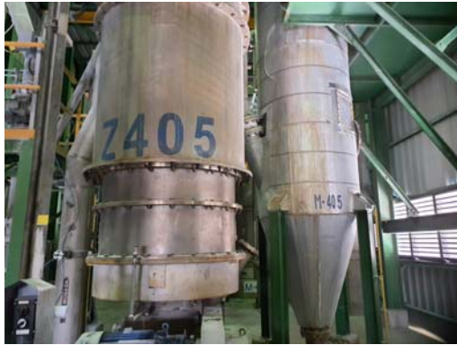
รูปที่ 3.1-6 ระบบดักฝุ่นแบบถุงกรอง (Bag Filter) (M-405)
