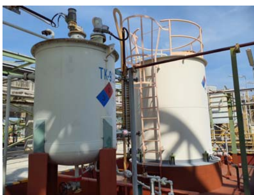
รูปที่ 3.1-44 คั่นคอนกรีต บริเวณถังเก็บกากโซเดียมไฮดรอกไซด์ (TK-922)
