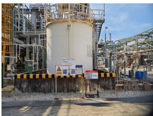
รูปที่ 3.1-40 คันคอนกรีตบริเวณถังเก็บสารเคมี
