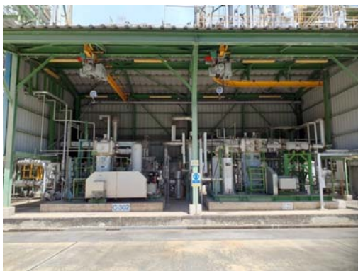
รูปที่ 3.1-4 Flash Gas Compressor (C-222)
