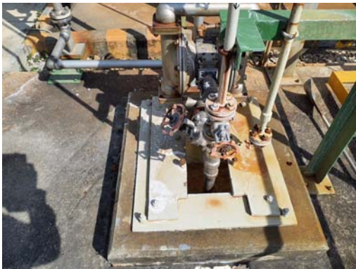
รูปที่ 3.1-15 ระบบ Level Switch (P-921)
