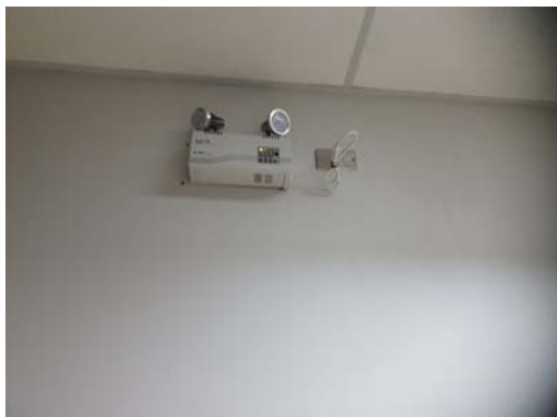
ระบบส่องสว่างภายในพื้นที่โครงการ กรณีฉุกเฉิน
