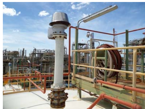
รูปที่ 3.1-5 ระบบที่รวบรวม Vent Gas
