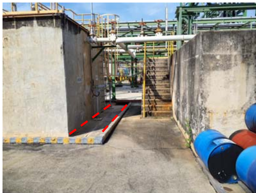
รูปที่ 3.1-19 พื้นที่คอนกรีตที่ลาดเอียง เข้าหาบ่อดักน้ำ (Catch Basin)
