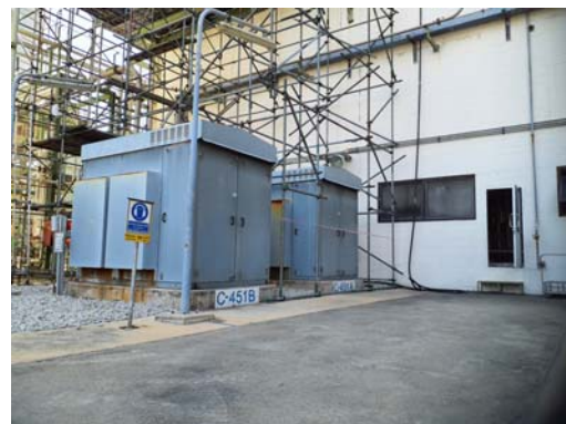
รูปที่ 3.1-22 อุปกรณ์ลดระดับเสียง (Sound Enclosure Cover Equipment)
